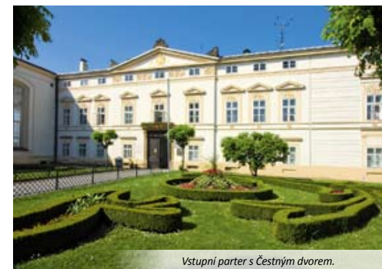
Vstupní parter s Čestným dvorem.
